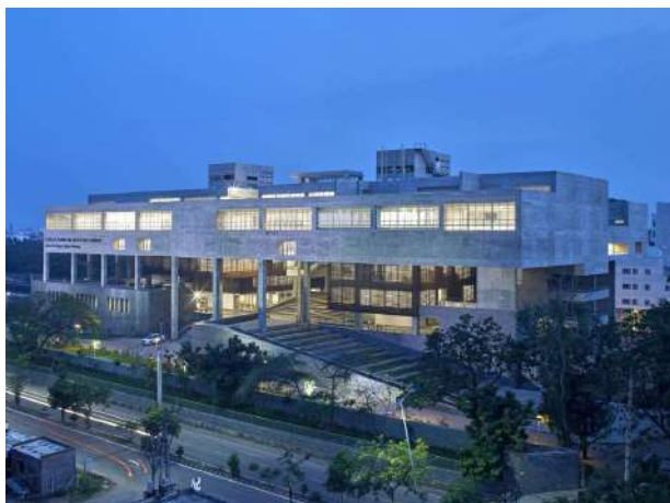
प्रशासनिक एवं शैक्षणिक ब्लॉक
